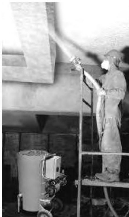
Рис. 1 Нанесение покрытия ФИБРОГЕЙН штукатурным агрегатом марки «Торнадо» (производства ПТК «А+В»).
